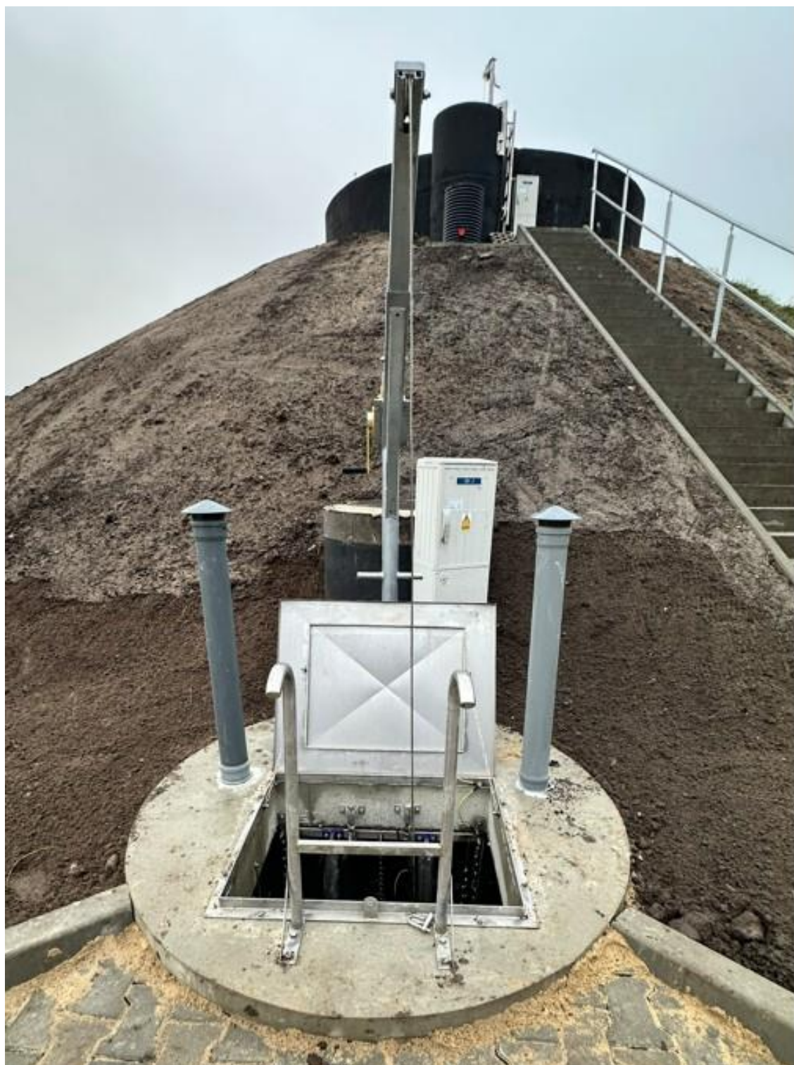
Zdjęcia nr 4 – Przepompownia główna i osadnik Imhoffa
