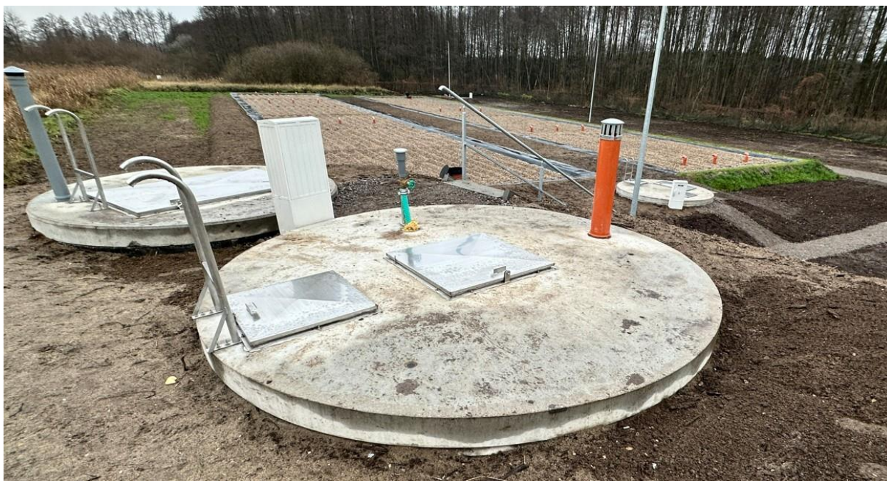
Zdjęcie nr 6: komora rozdziału i filtry z przepływem pionowym
