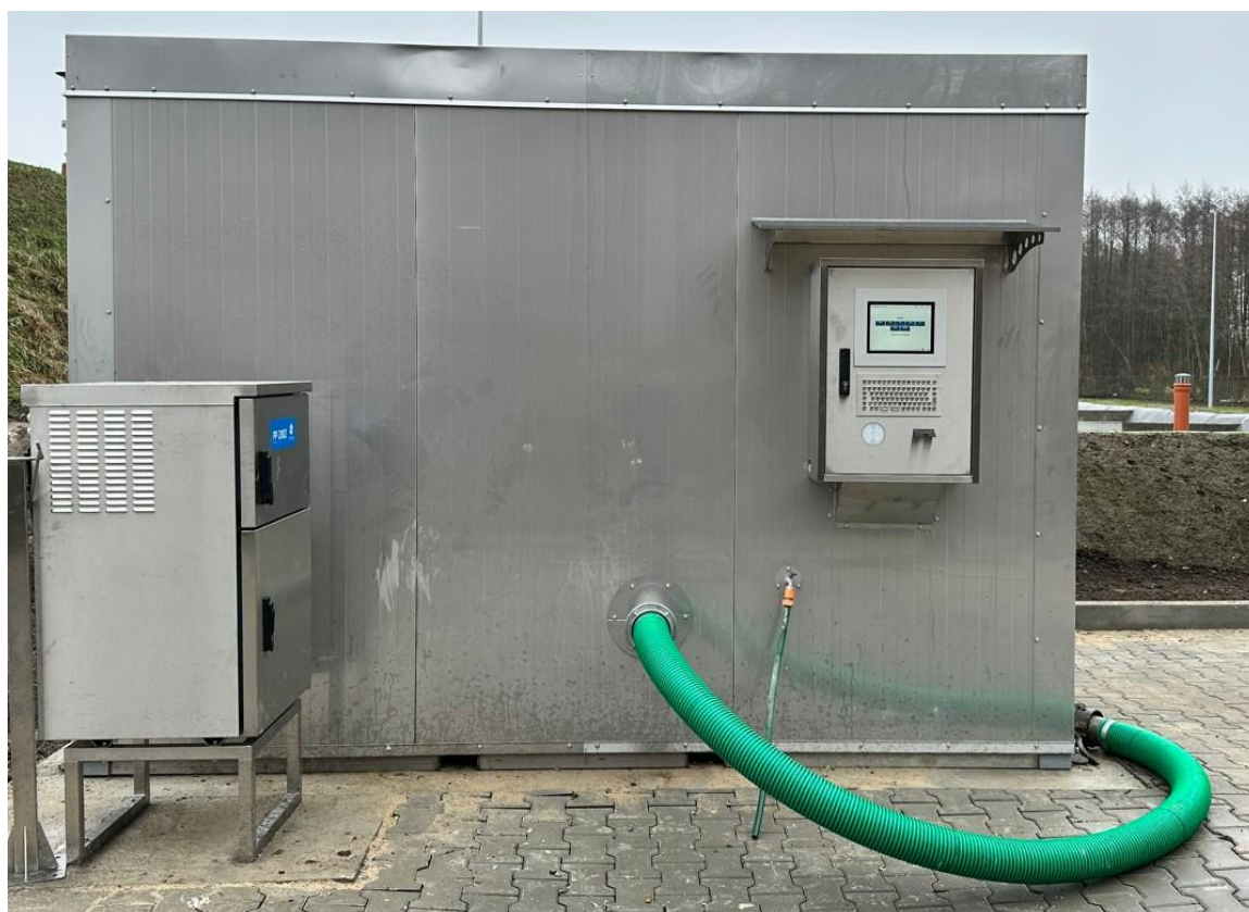
Zdjęcia nr 2: Stacja zlewna ścieki dowożone
